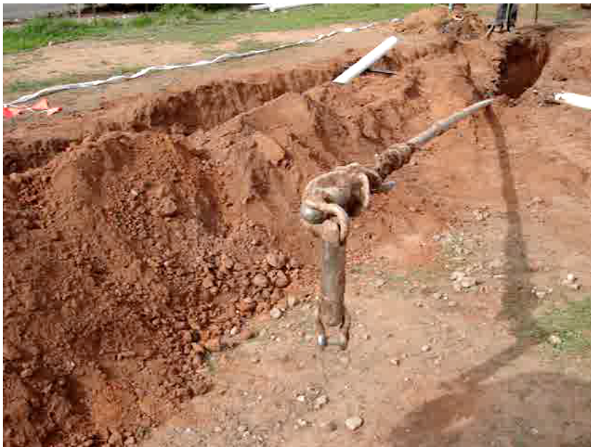
Hauling conduit - part 1
