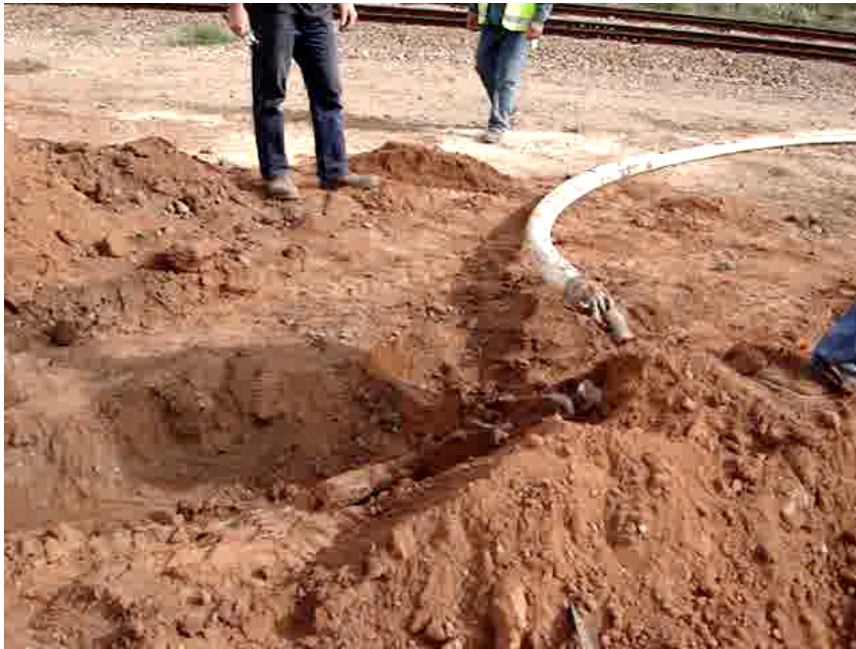
Hauling conduit - part 2
